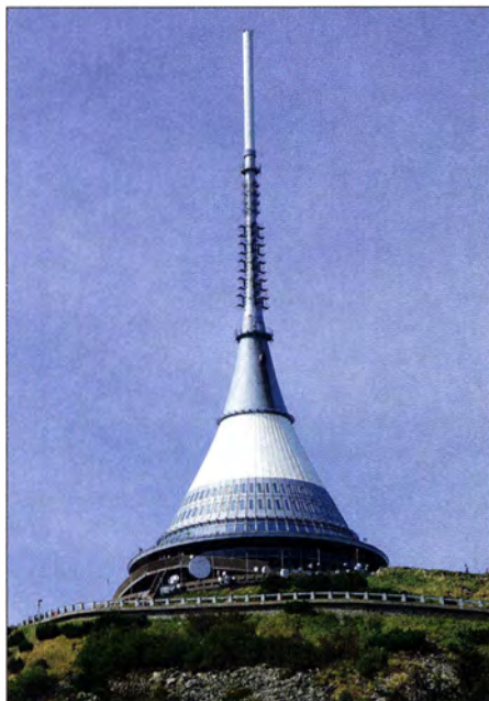
Das weithin sichtbare Gebäude auf dem Jeschken wird von einem Sendeturm zur Abstrahlung von Rundfunkprogrammen gekrönt.
