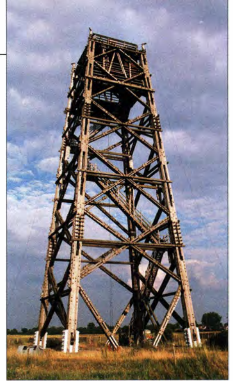
Der „Messturm 2“ in Brück blieb von einem Brand im Jahr 1979 verschont, während der baugleiche „Messturm 1“ dem damaligen Unglück zum Opfer fiel.
