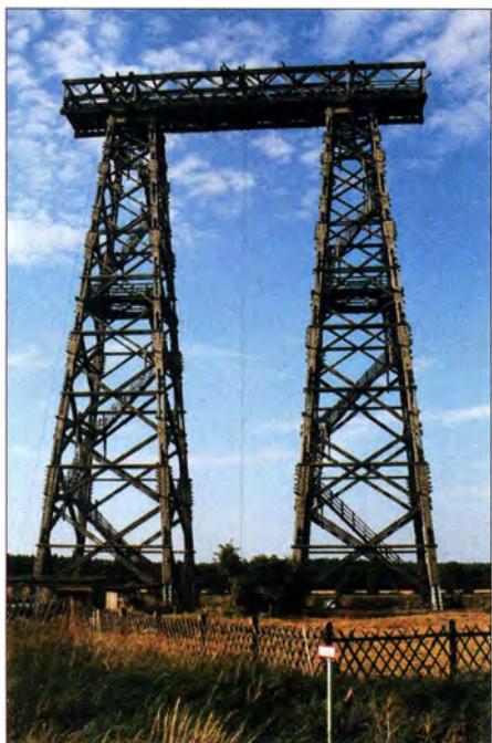
Die Spitzen des hölzernen Zwillingssturms in Brück (Messturm 3) verbindet ein 35 m langer und 5 m breiter Querträger.
